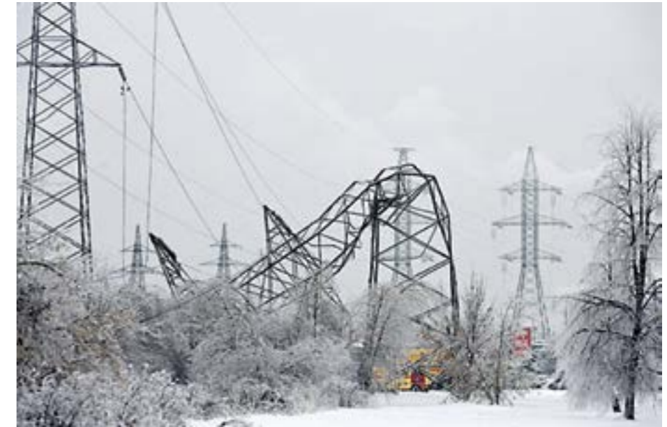
Рис. 1. Последствия обледенения ЛЭП
